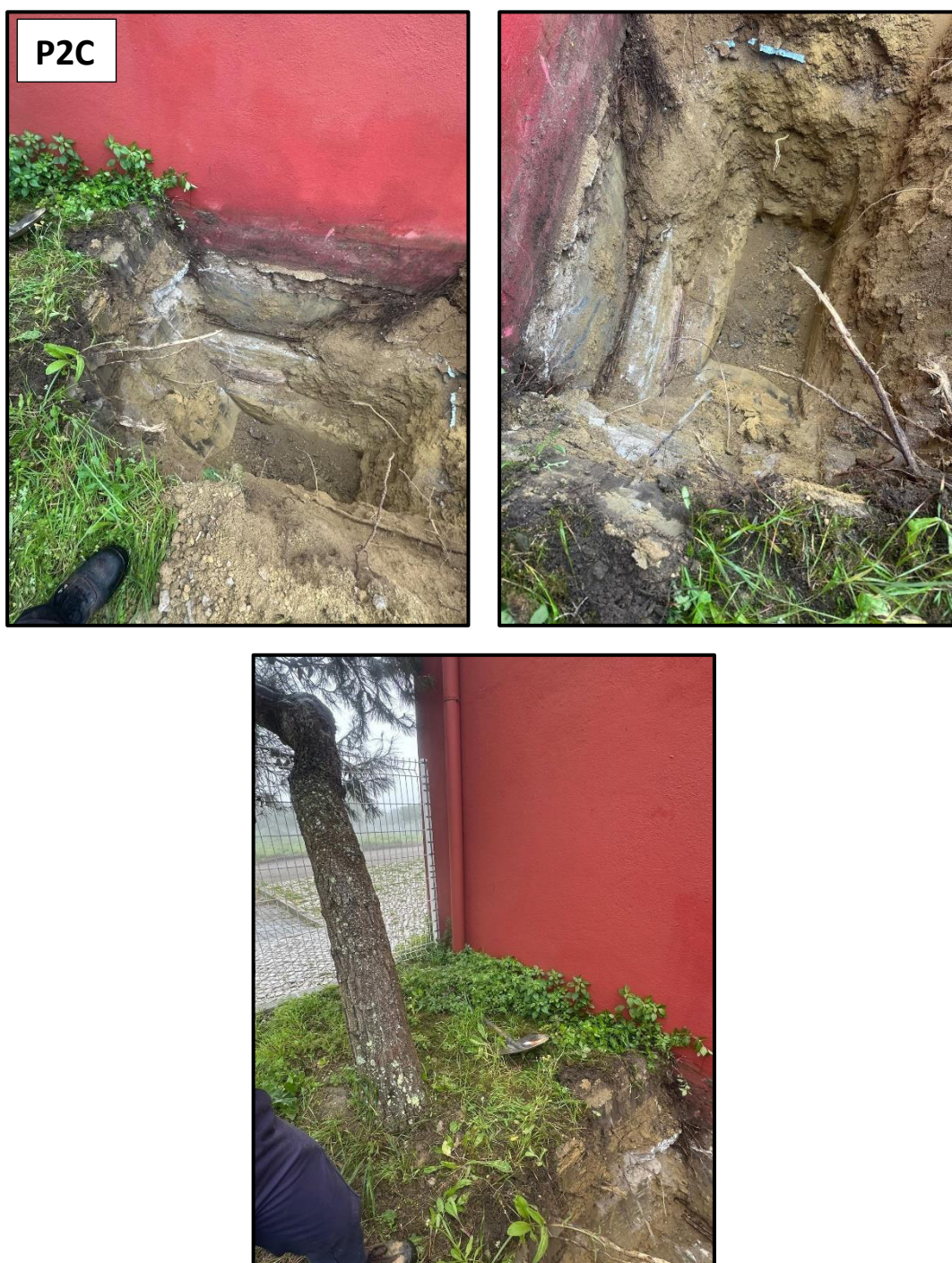
Figura 9: Aspectos de execução dos poços de investigação de fundações.
