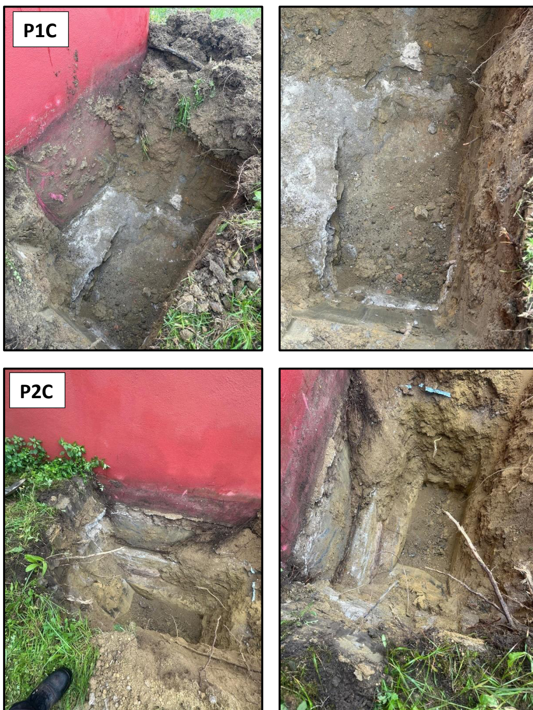
Figura 6: Alguns aspetos de execução dos poços de investigação de fundações.
